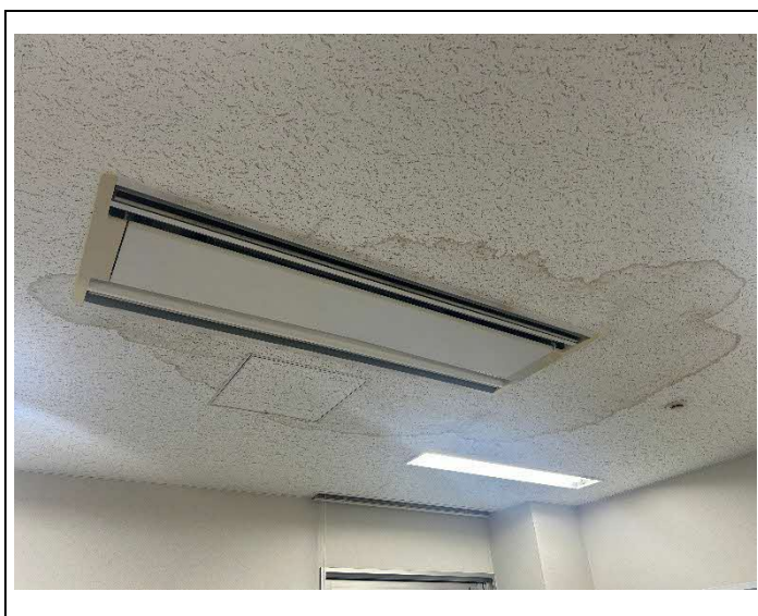
写真 No.7 天井
