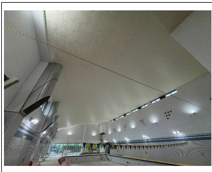
写真 No.13 天井
