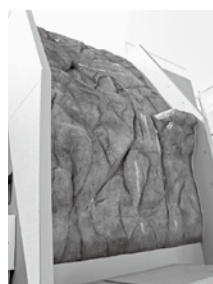
◀高さ10メートル、傾斜60度の山肌が再現された山岳訓練施設
