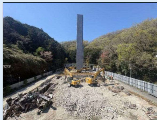
南和広域美化センター 解体工事実施状況
