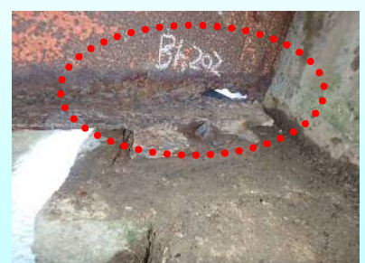
主桁の損傷（腐食）
