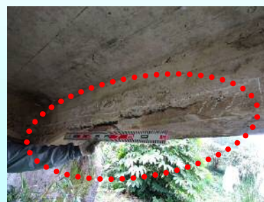
主桁の損傷（鉄筋露出）
