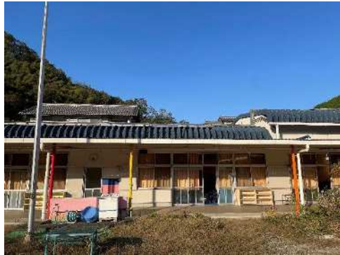
屋根 (太陽光パネル)
